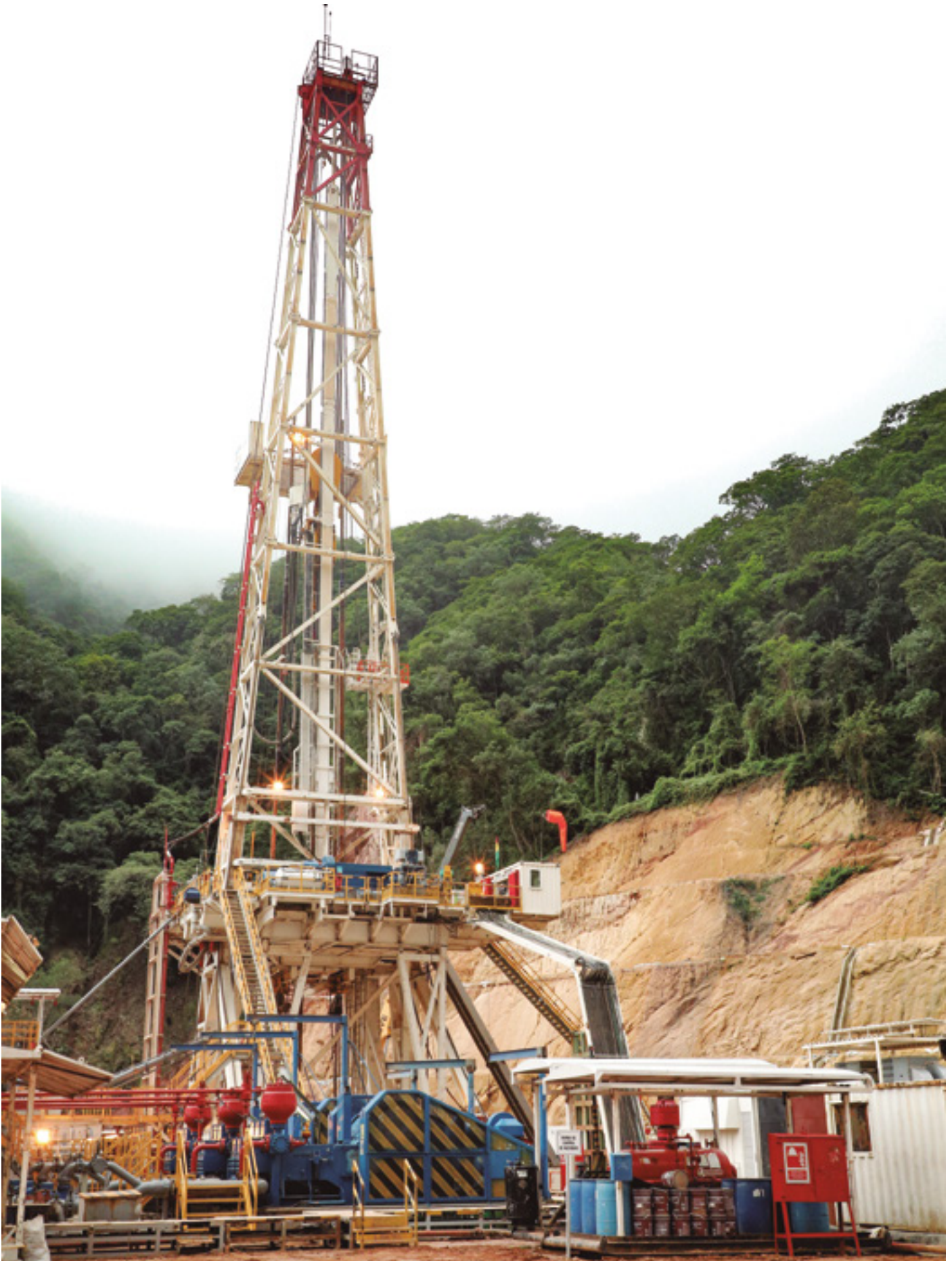
Pozo de exploración de hidrocarburos.
