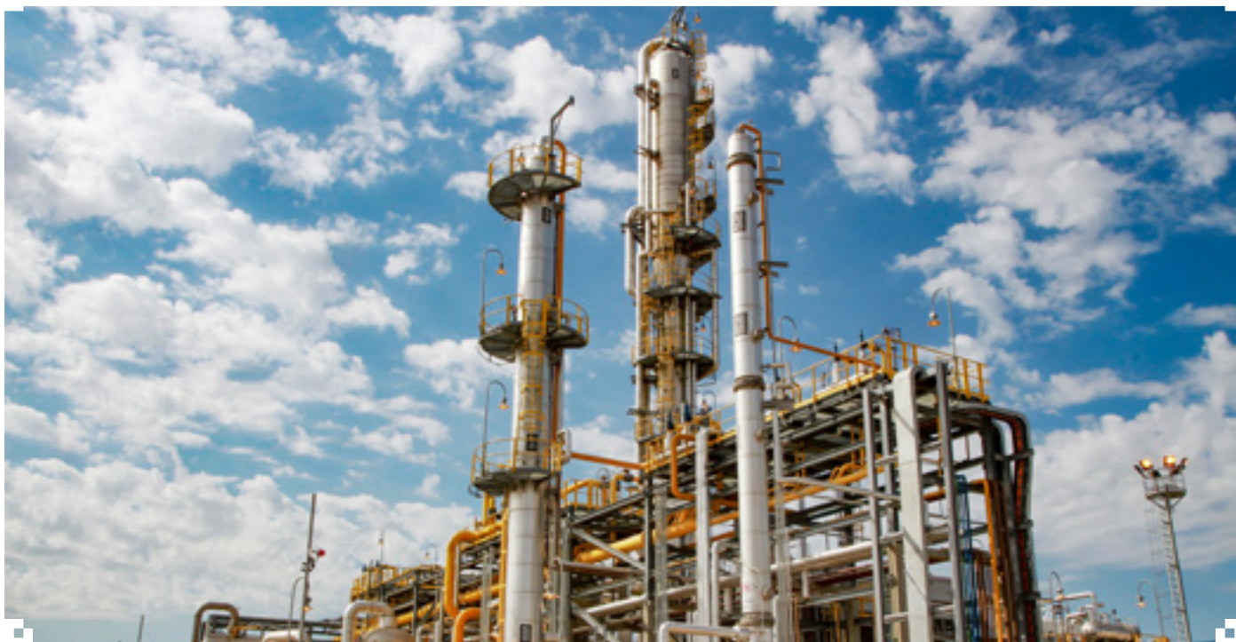
Planta Separadora de Líquidos Rio Grande en Santa Cruz.
