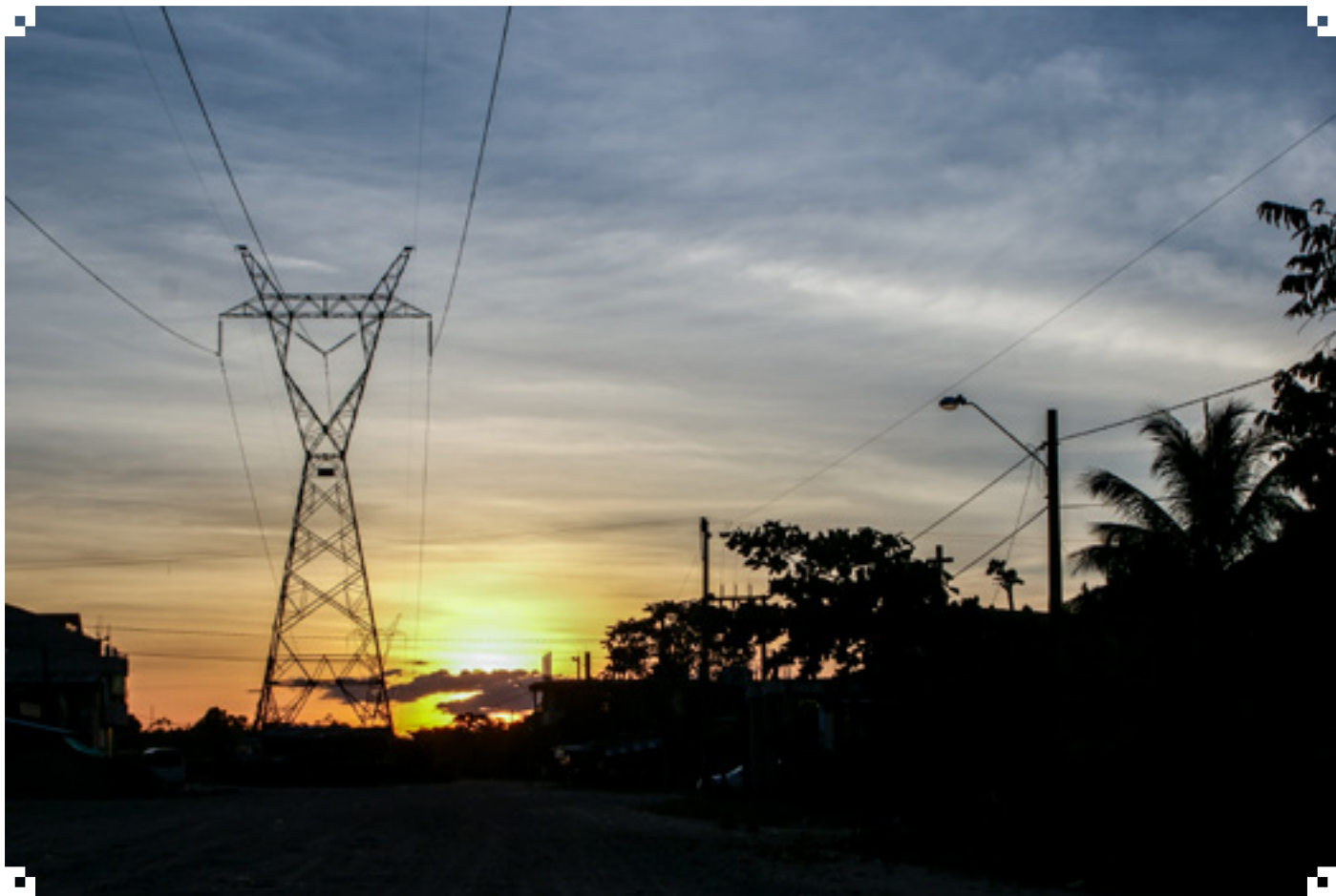
La línea eléctrica del proyecto Juana Azurduy de Padilla concluye este 2022.
