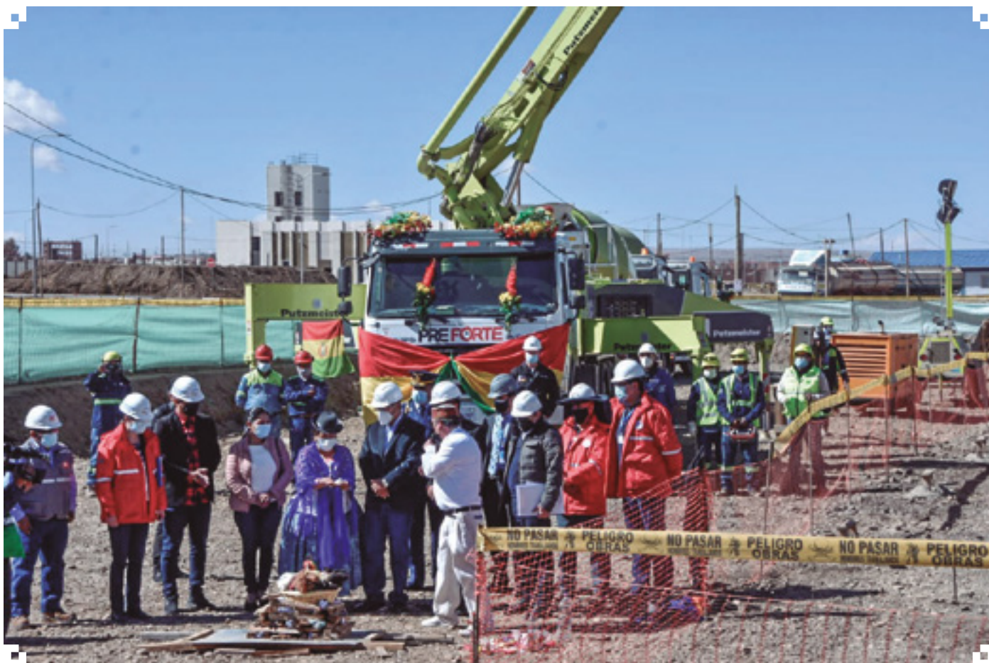
Vaciado del primer hormigón del Reactor Nuclear de Investigación en Parcopata, El Alto Fuente: Agencia Boliviana de Información (ABI).
