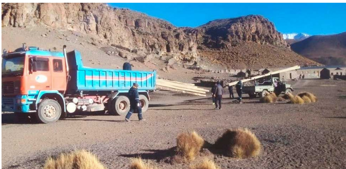
Personal hace el colocado de postes. Foto/ Archivo
