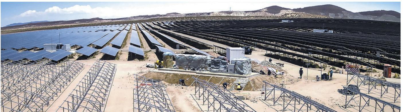
Las estructuras metálicas que se instalaron tendrán la función de soportar los paneles solares.
