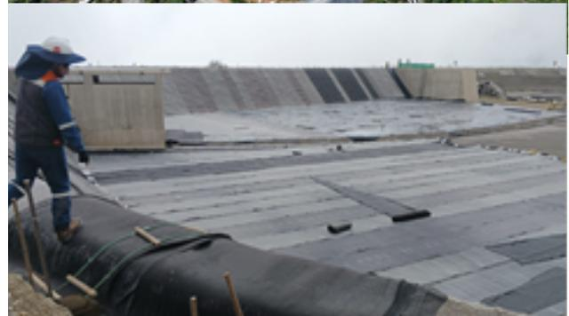
**Vista aérea de colocado de geomembrana en la cámara de carga.**
