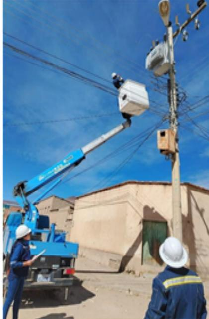
Foto: Instalación de registrador, Challapata, Oruro.
