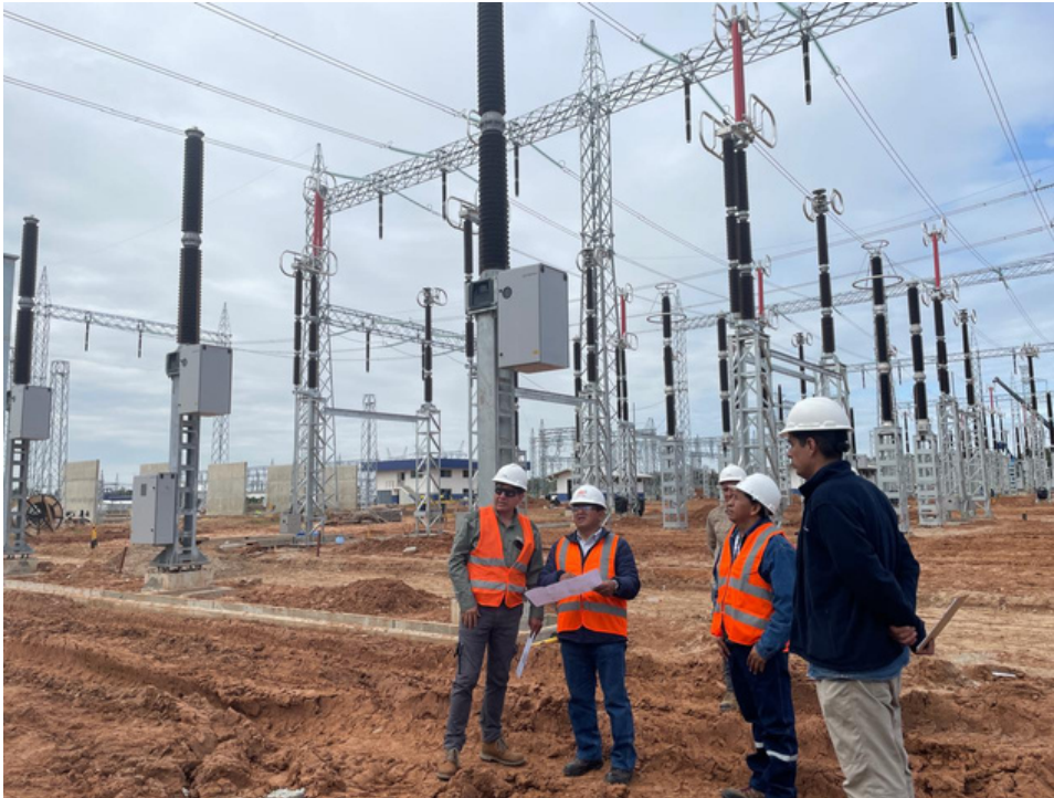
Foto: Inspección subestación Brechas
